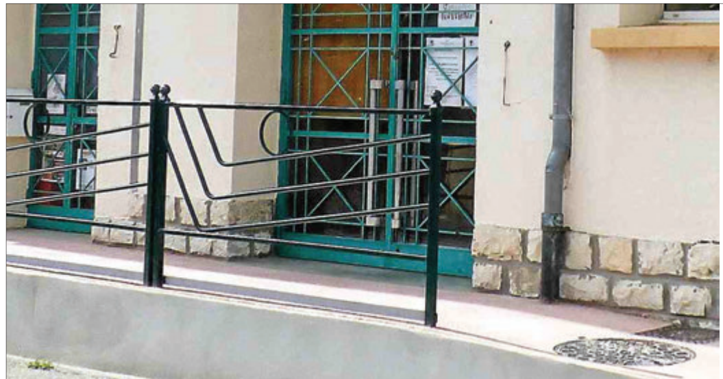
L'accès handicapé a été réalisé devant l'entrée.
