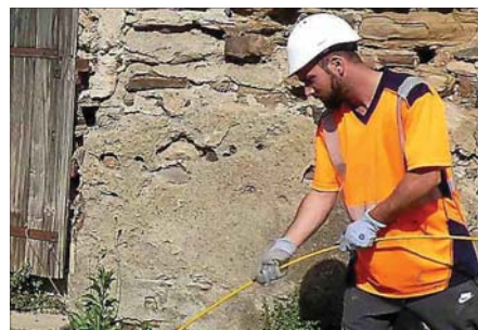
■ Les câbles sont installés dans la rue des Poilus.
